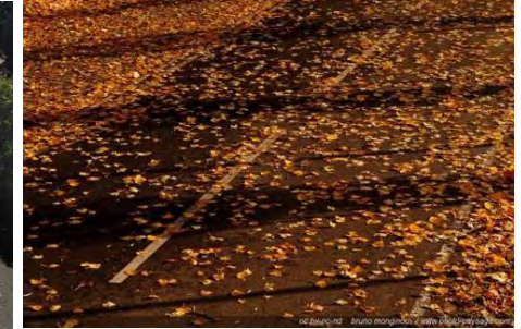
Feuilles sur aménagement — risque de chute
