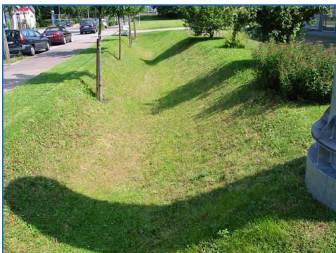
Noue d'infiltration végétale
