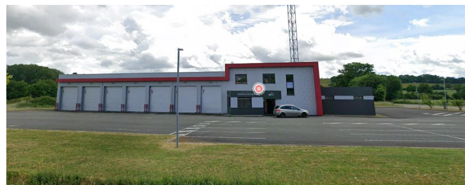
Centre de secours à Saint-Rémy-de-Sillé – Google maps
