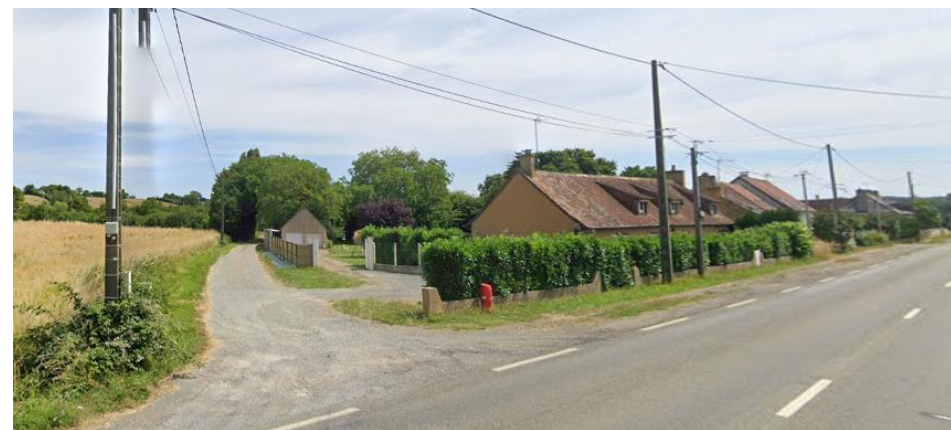
Vue sur l'entrée du site - extrait Google Maps
